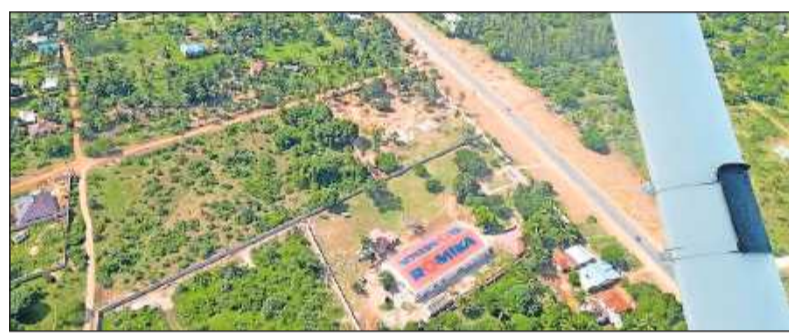
Auf dem Gelände der neuen Romika-Fabrik wird jetzt noch ein Gebäude für eine Online-Schule gebaut.
